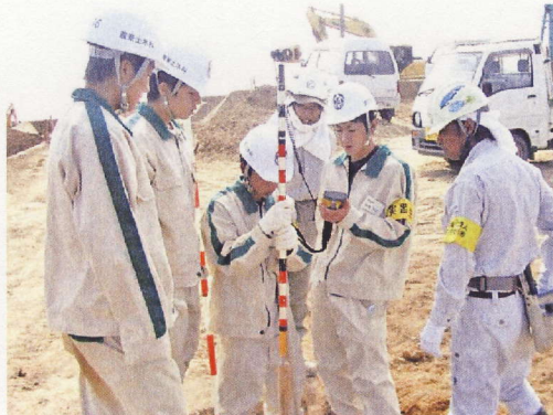
山本建設 追尾式測量機を使用する生徒
