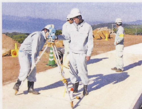
トランシットの据え付け状況
