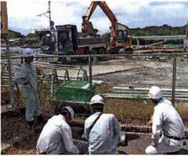
日野川河川改修工事
