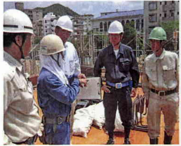
滑石団地(高耐)建築工事
